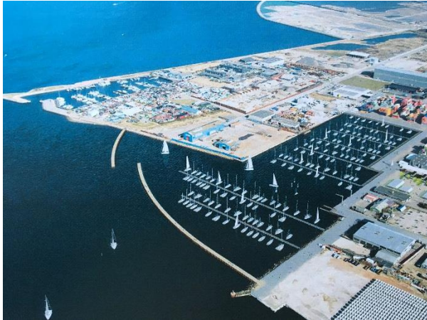
Erstatningshavn i "Færgehavn nord"
